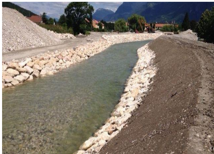
Aménagement des berges du Furon à Sassenage pour prévenir les inondations (Isere).
